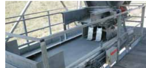
Abzugsbandwaage in Verladung
